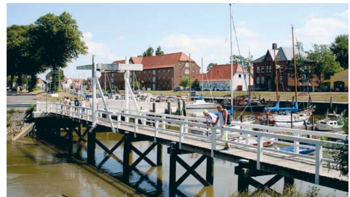
Hafen mit Packhaus
